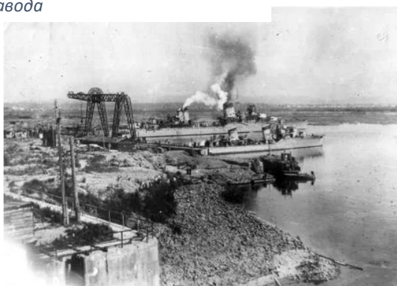
Иллюстрация 8: Амурский судостроительный завод
